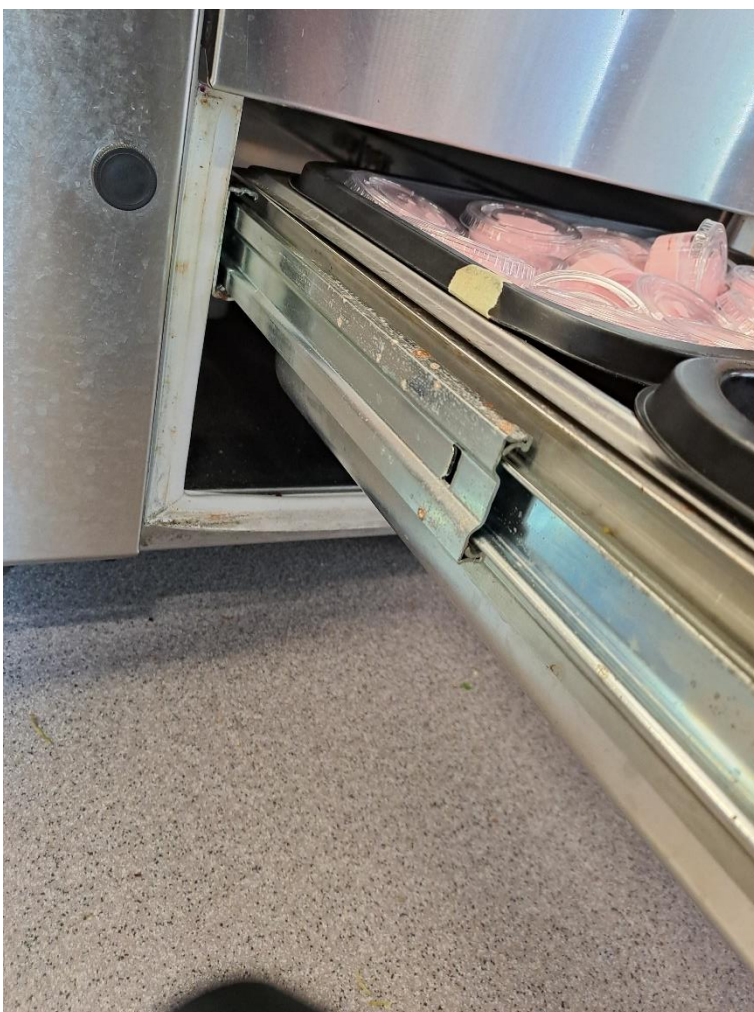
Kuva 2. Kylmävetolaatikostojen tiivisteissä oli likaa ja mahdollista hometta.
