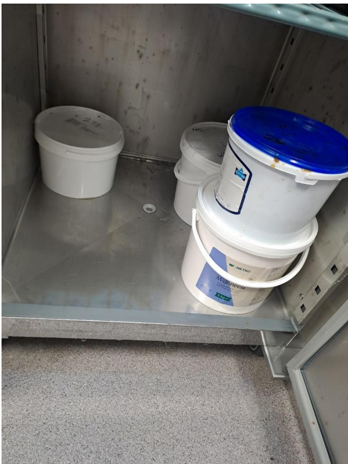
Kuva 6. Kylmäkaapin kondenssiveden poistoputki on laitteen pohjalla. Hankkikaa alimmalle tasolle hylly, jotta elintarvikkepakkaukset eivät ole kondenssiveden seassa.
