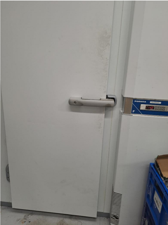
Kuva 3. Kellarin pakastinhuoneen ovi oli likainen kosketuspinnolta.
